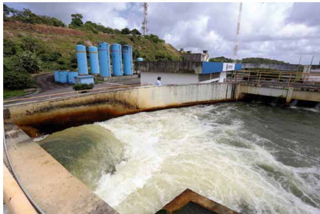
Estação de Tratamento de Água Pirapama
