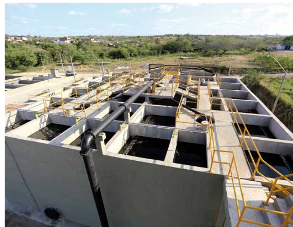
Estação de Tratamento de Esgoto de Surubim
