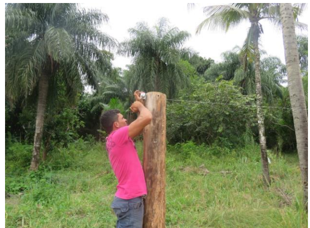
Figura 93 – Catracas fixadas nos mourões e os arames esticados
