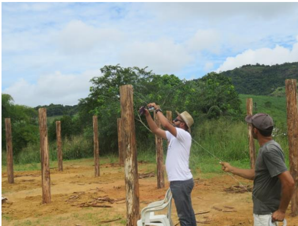
Figura 78 – Catracas fixadas nos mourões e os arames esticados
