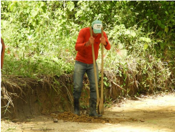
Figura 88 – Abertura das covas para fixação dos mourões do viveiro no Assentamento Soledade
