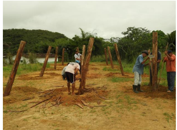
Figura 77 – Fixação dos mourões no solo para sustentação do sombrite durante a instalação do viveiro no Assentamento Gaipió
