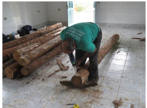
Figura 75 – Perfuração dos mourões com broca para madeira durante a instalação do viveiro no Assentamento Gaipió
