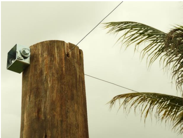
Figura 61 – Catracas fixadas nos mourões e os arames esticados
