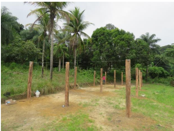
Figura 92 – Fixação dos mourões no solo para sustentação do sombrite durante a instalação do viveiro no Assentamento Soledade
