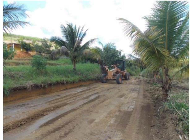
Figura 50 – Terraplanagem da área para instalação do viveiro no Assentamento Amazonas
