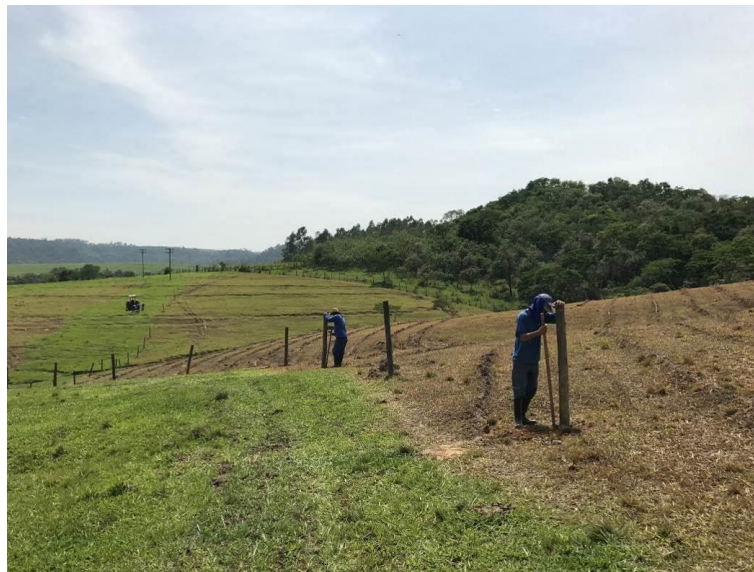
Figura 4 – Exemplo de instalação de cerca para evitar o pastoreio de animais nas áreas de recuperação
