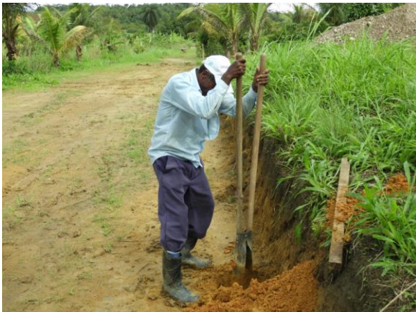
Figura 55 – Abertura das covas para fixação dos mourões do viveiro no Assentamento Amazonas
