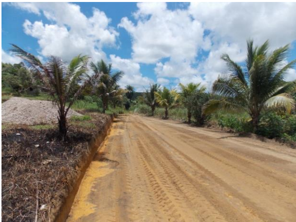
Figura 51 – Área do viveiro após a finalização da atividade de terraplanagem no Assentamento Amazonas
