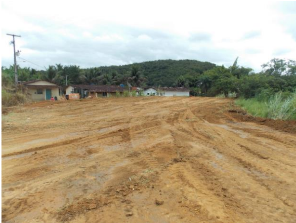
Figura 70 – Área do viveiro após a finalização da atividade de terraplanagem no Assentamento Gaipió
