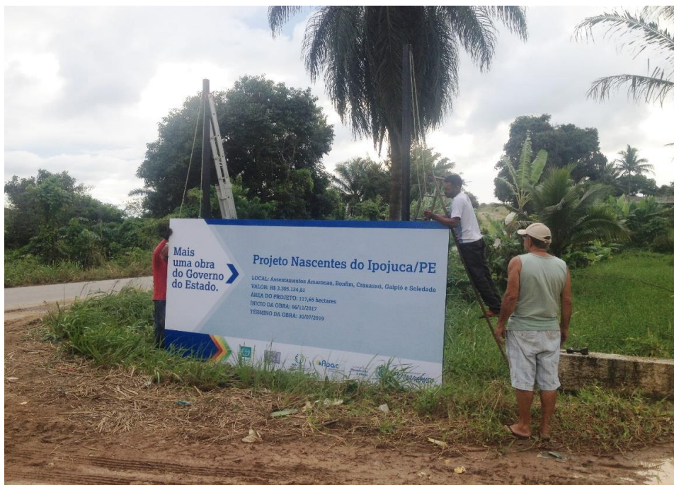
Figura 21 – Instalação da Placa de Execução de Obras Assentamento Amazonas, Ipojuca/PE
