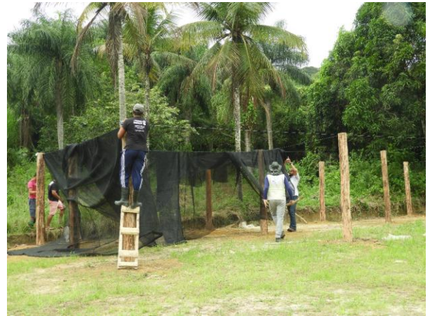
Figura 97 – Fixação do sombrite sobre os mourões e fios de arames durante a instalação do viveiro no Assentamento Soledade
