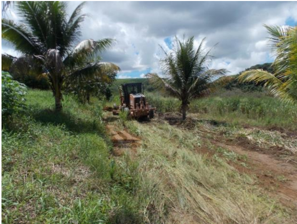
Figura 49 – Limpeza da área e retirada dos capins e herbáceas no local de implantação do Viveiro no Assentamento Amazonas
