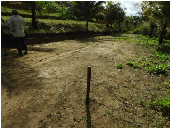
Figura 53 – Área de Casa de Sombra devidamente delimitada e esquadrejada para a construção do viveiro no Assentamento Amazonas
