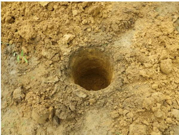
Figura 57 – Detalhe de cova para fixação de mourão no Assentamento Amazonas
