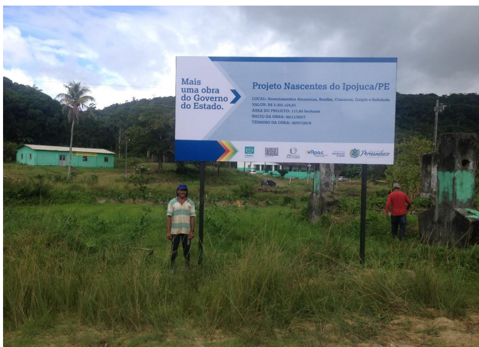
Figura 24 – Instalação da Placa de Execução de Obras Assentamento Soledade, Ipojuca/PE
