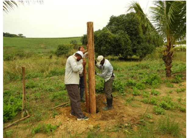
Figura 60 – Fixação dos mourões no solo para sustentação do sombrite durante a instalação do viveiro no Assentamento Amazonas
