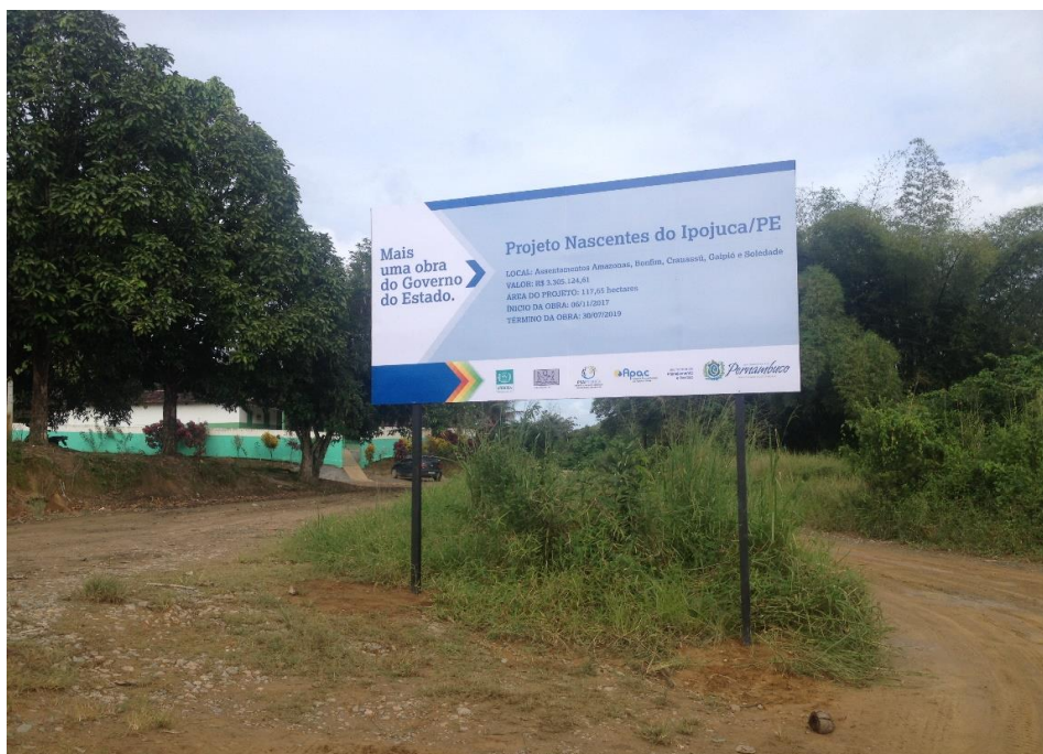
Figura 28 – Placa de Execução de Obras Assentamento Gaipió, Ipojuca/PE
