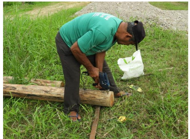
Figura 58 – Perfuração dos mourões com broca para madeira durante a instalação do viveiro no Assentamento Amazonas
