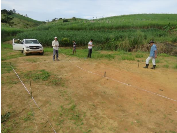
Figura 72 – Área de Casa de Sombra devidamente delimitada e esquadrejada para a construção do viveiro no Assentamento Gaipió
