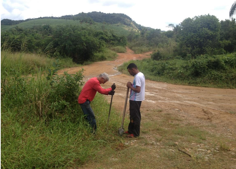
Figura 26 – Instalação da Placa de Execução de Obras Assentamento Gaipió, Ipojuca/PE
