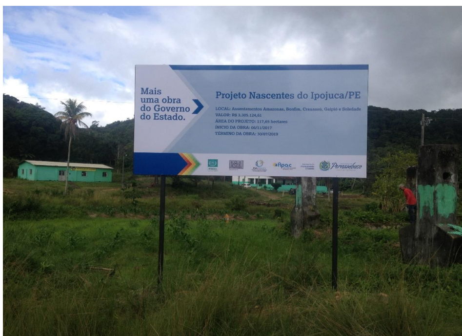
Figura 25 – Placa de Execução de Obras Assentamento Soledade, Ipojuca/PE
