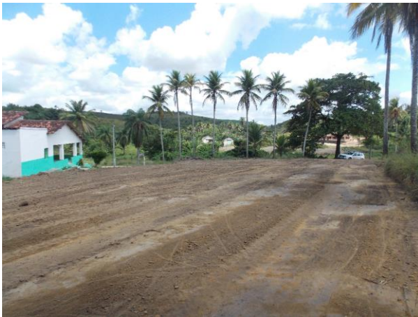
Figura 84 – Área do viveiro após a finalização da atividade de terraplanagem no Assentamento Soledade
