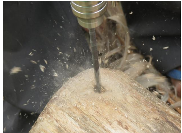
Figura 91 – Perfuração dos mourões com broca para madeira durante a instalação do viveiro no Assentamento Soledade
