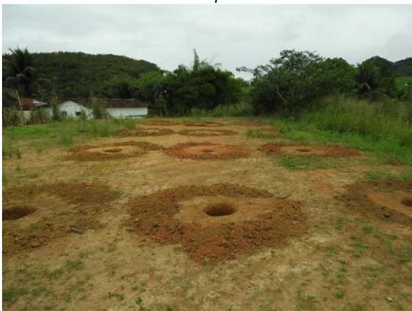
Figura 74 – Vista geral da abertura de covas no local do viveiro no Assentamento Gaipió
