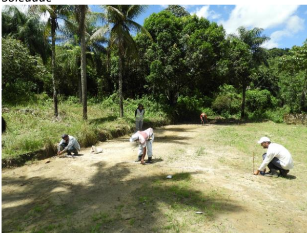
Figura 86 – Área de Casa de Sombra devidamente delimitada e esquadrejada para a construção do viveiro no Assentamento Soledade
