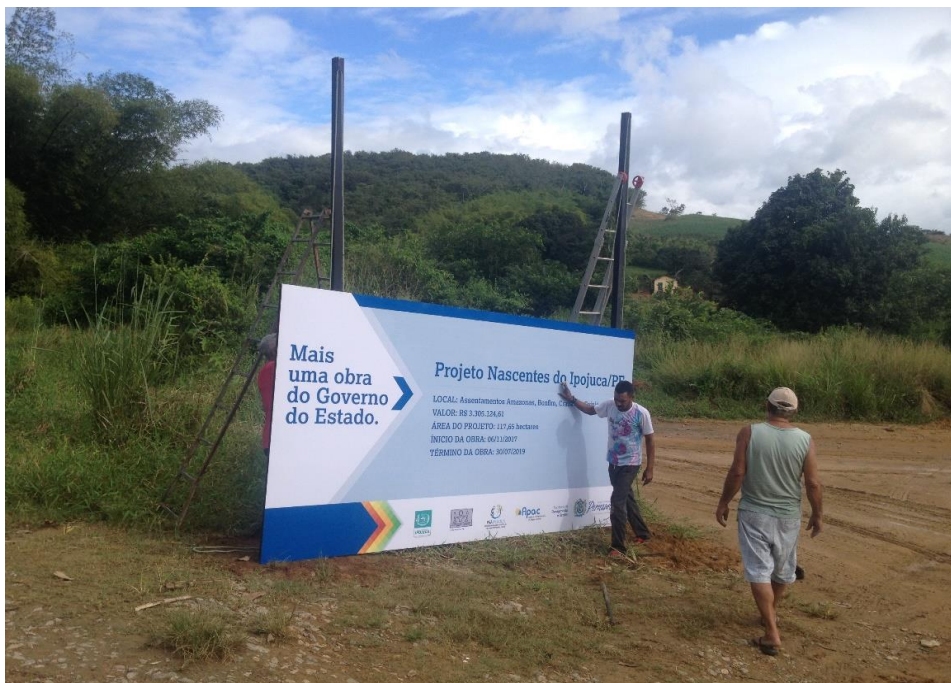
Figura 27 – Instalação da Placa de Execução de Obras Assentamento Gaipió, Ipojuca/PE
