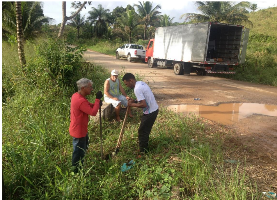
Figura 20 – Instalação da Placa de Execução de Obras Assentamento Amazonas, Ipojuca/PE
