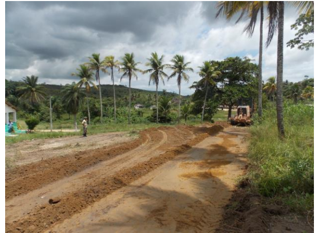
Figura 83 – Terraplanagem da área para instalação do viveiro no Assentamento Soledade
