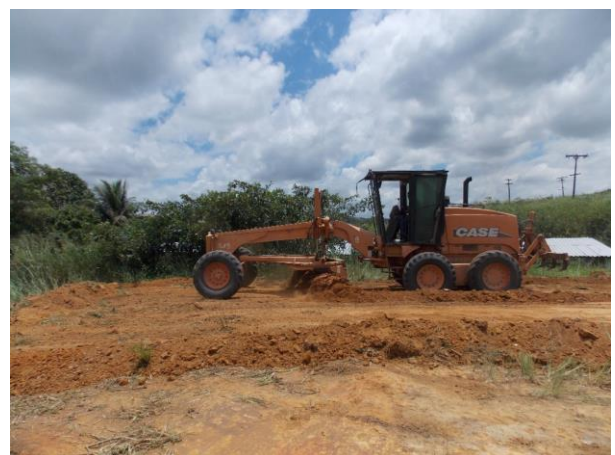
Figura 69 – Terraplanagem da área para instalação do viveiro no Assentamento Gaipió
