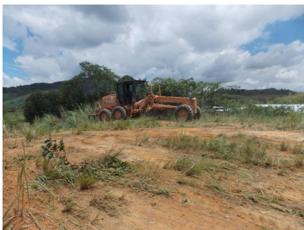
Figura 68 – Limpeza da área e retirada dos capins e herbáceas no local de implantação do Viveiro no Assentamento Gaipió
